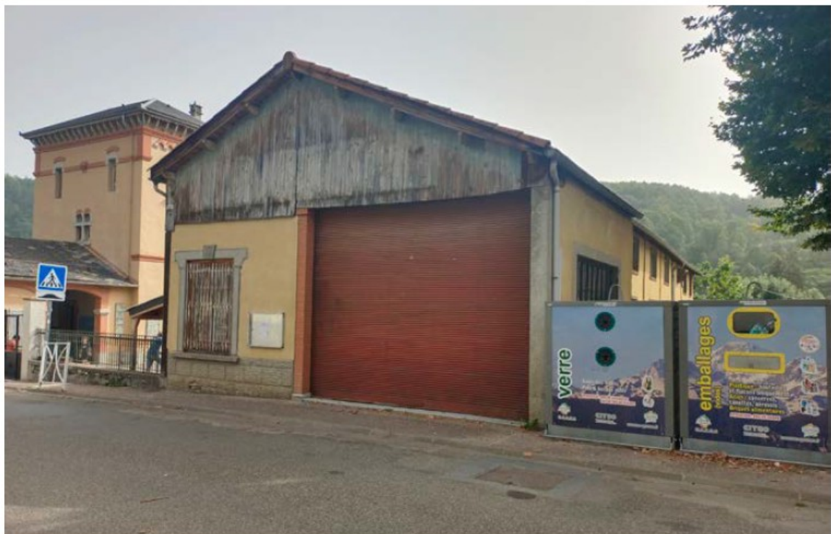
Façade sur la rue
